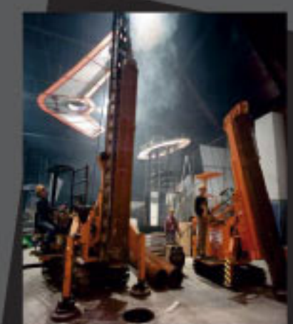
Heiwerk TV-studio's Aalsmeer
