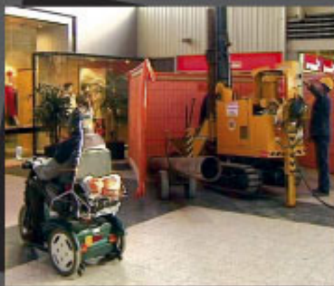
Heien in beperkte ruimte winkelcentrum te Gorinchem
