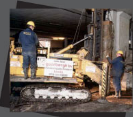
Versterken fundering parkeergarage te Spijkenisse
